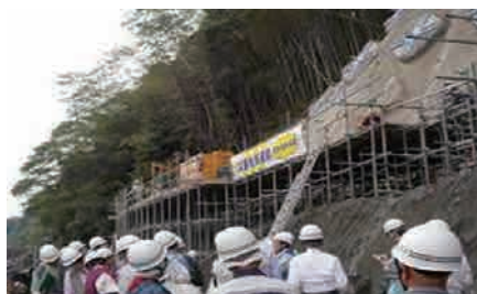
災害復旧地・工事現場
